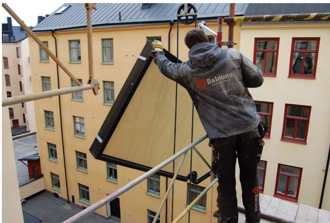
Balkongplattan hissas upp och monteras.
