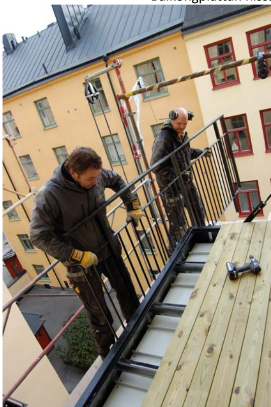
Balkongräcket monteras. Befintlig radiator flyttas eller ersätts med ett nytt vid sidan av dörren.
