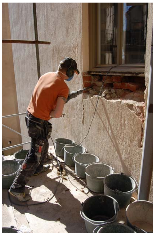
Fönsterbröstning bilas bort inför montering av fönsterdörr.
